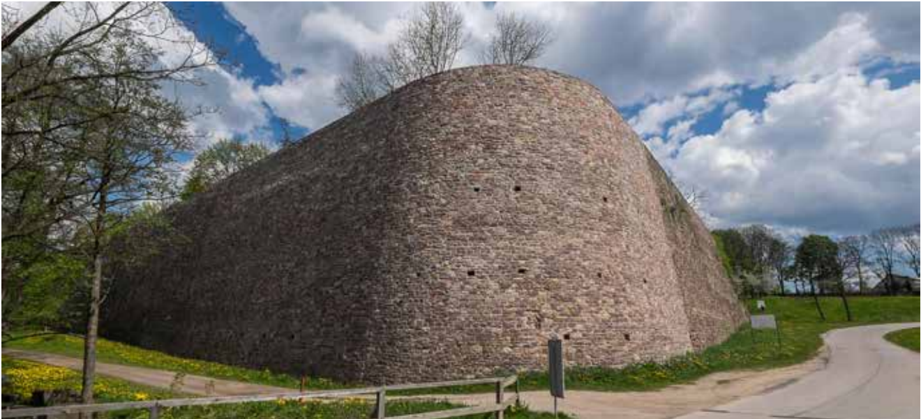
Bobrza pod Kielcami. Mur oporowy kompleksu hutniczego wybudowany w latach 1828–1831. Przypuszczalny końcowy etap trasy ewakuacji zasobów Banku Polskiego
