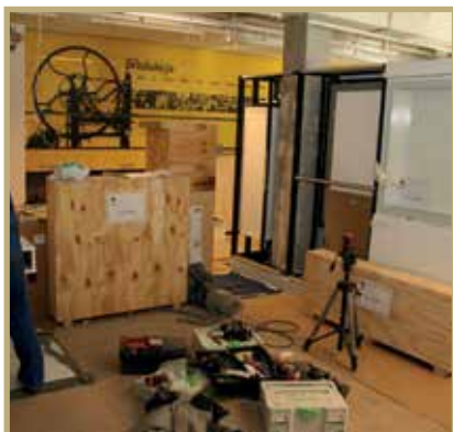
Prace wykonawcze, wrzesień-październik 2015 r.
