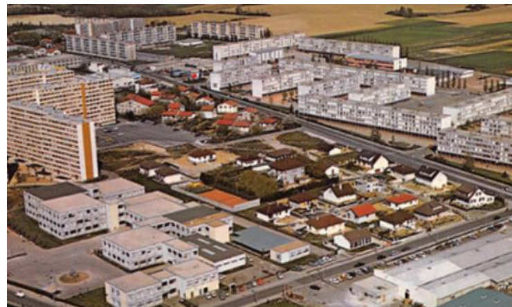
La Grappinière Vaulx en Velin (69) 1970
